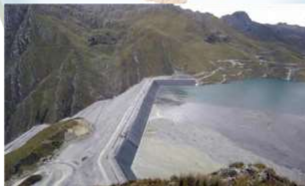
شکل ۳- سد باطله معدن آنتامینا؛ پرو (۳).
