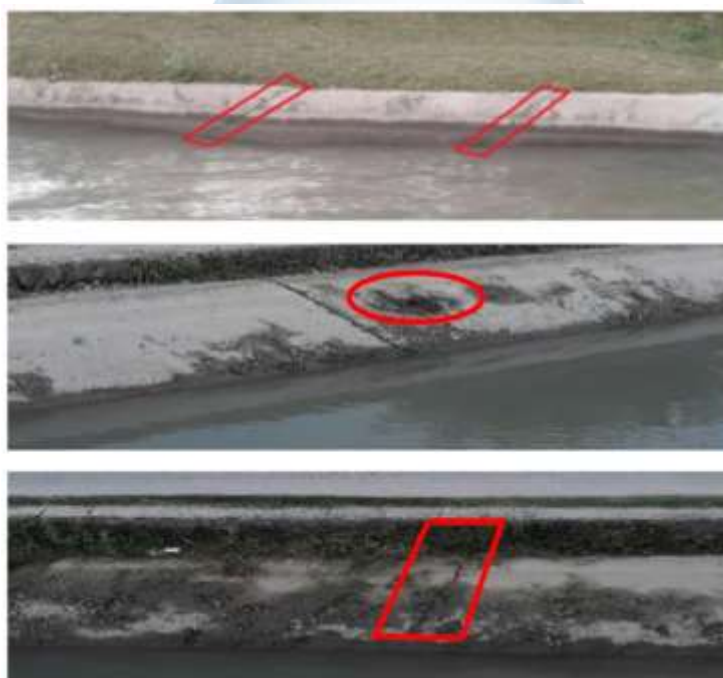
شکل (۱) نمونه‌ای از ترک‌های مورب، توده‌ای و موازی در کانال‌های بتنی (۸)
