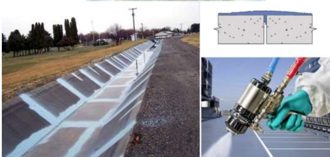
شکل (۴) پیسوله پلی اوره گرم، اصلاح ترک با استفاده از پلی اوره و نمایی از پوشش کانال ترمیم شده بوسیله پلی اوره
