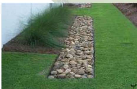
شکل ۸-الف: شماتیک اجرایی ترانشه نفوذ شکل، ب: اجرای ترانشه نفوذ [۲۳ و ۳۲]
