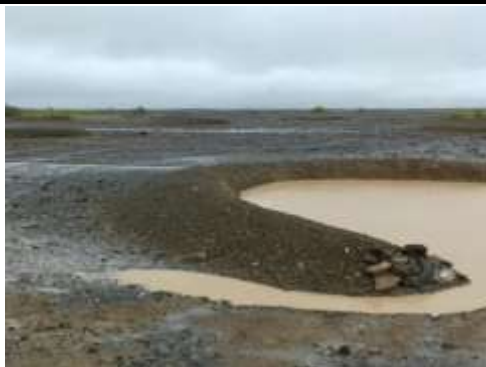
شکل (۳): نمایی از هلالی‌های آبگیر احداث شده در دشت گوهرکوه
