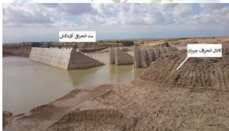
شکل ۵- بند انحرافی و کانال انتقال آق دکش
