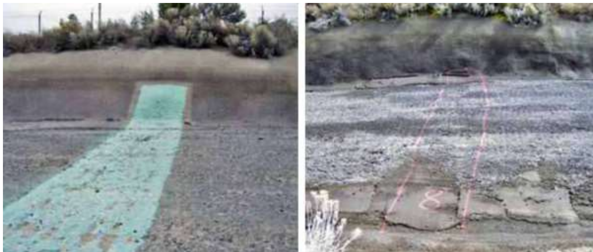
شکل (۲) پوشش قسمتی از کانال آبیاری ایالت اورگون ۱ با استفاده از آکوالاستیک (۶)
