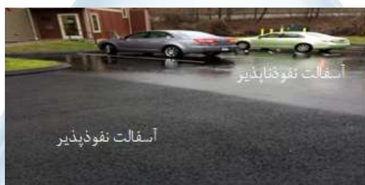
شکل ۳- تفاوت آسفالت معمولی با نفوذپذیر [۲۸]
