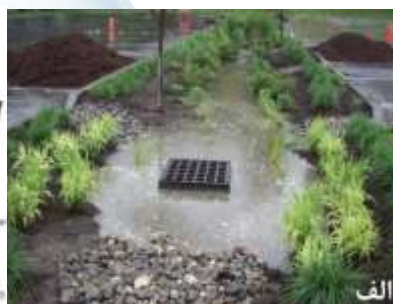
شکل ۷-الف: سیستم ماند بیولوژیکی، ب: جزئیات اجرایی سیستم ماند بیولوژیکی [۳۱]
